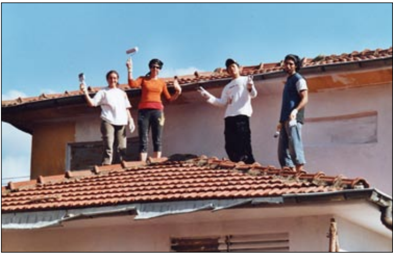
Malování na budovu se neobešlo bez lezení po střeše.
